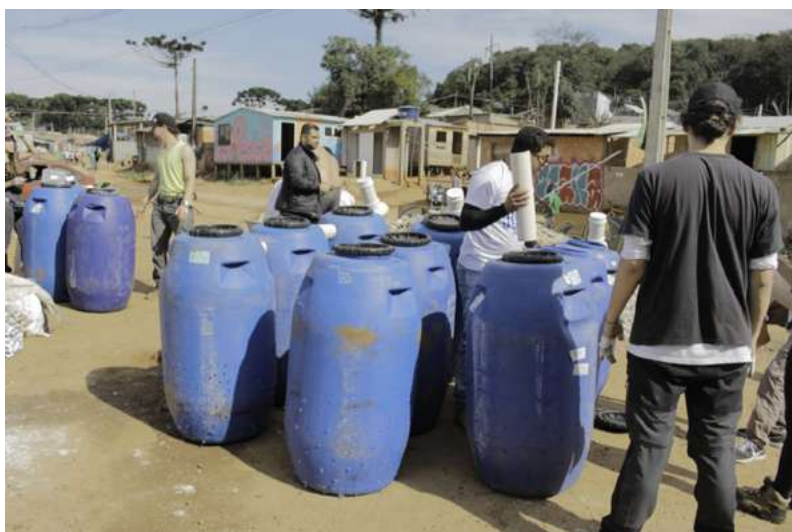
Congresso do Povo, construção de biofossas Acervo MST
